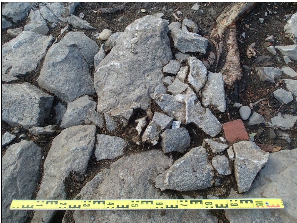
Kuva 54. Betonia rakenteessa R3B (seinärakenne). Kuvattu etelään.
