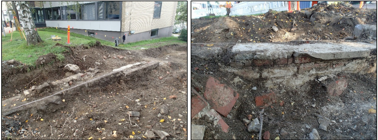
Kuva 37 (vas.) ja kuva 38 (oik.). Moderni rakennuksen perustus Alueen 1 kaakkoiskulmassa, aikaisemman, kevään 2014 muinaisjäännöskartoituksen koekuopan 6 (KK6) kohdalla. Kuvat lounaaseen.
