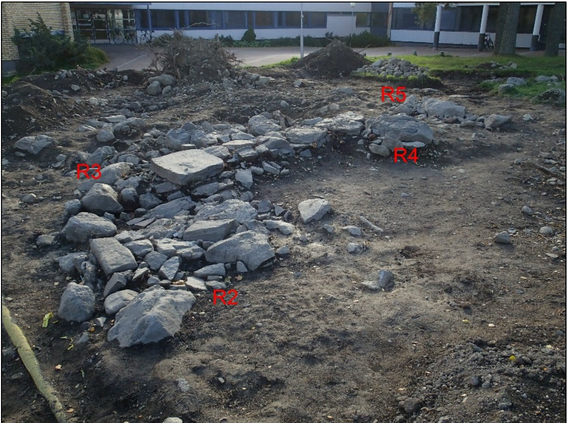
Kuva 42. Rakenteet R2 (tulisijan perustus), R3–R4 (seinän perustukset) ja R5, (kiveys) kaivettu esiin. Kuvattu lounaaseen.
