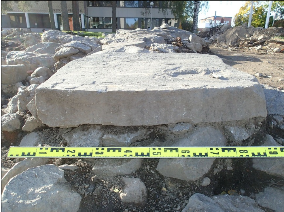
Kuva 51. Rakenne R3, laattakivi seinän kiviperustuksessa. Yksityiskohta. Kuvattu länsilounaaseen.
